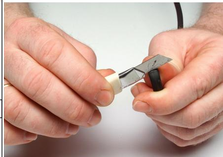
**Bild 2:** Ritzen Sie mit leichtem Druck die äußere Isolierung des Kabels ein, bis Sie auf die kupferfarbenen Abschirmung stoßen. Achten Sie nicht nur auf Ihre Finger, sondern seien Sie vorsichtig, damit Sie die Abschirmung nicht zerstören. Üben Sie das Abisolieren zunächst an Kabelresten. Als alternatives Werkzeug können Sie auch eine spezielle Abisolierzange im Baumarkt erwerben. Aber auch hier sollten Sie, zumindest was das Kabel angeht, Vorsicht walten lassen.
